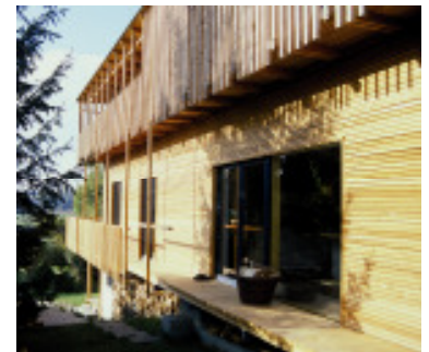
Holz ist ein leistungsfähiger Dämmstoff, der im Sommer vor Hitze und im Winter vor Kälte schützt (Bild: Augsburger Holzhaus GmbH).
