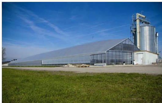
Trocknungsanlage in Alerheim: (Bild: Steinbacher-Consult Ingenieurgesellschaft mbH & CO.KG)
